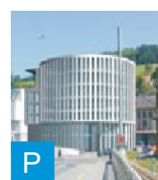
Parkhaus Vadianstrasse 57/59 Einfahrt über die Pestalozzistrasse
